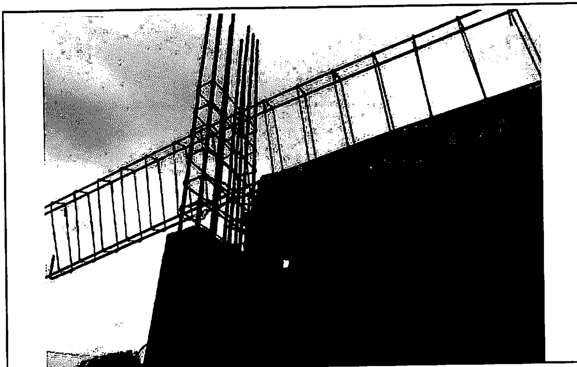
Foto 07: Armção Superestrutura.
