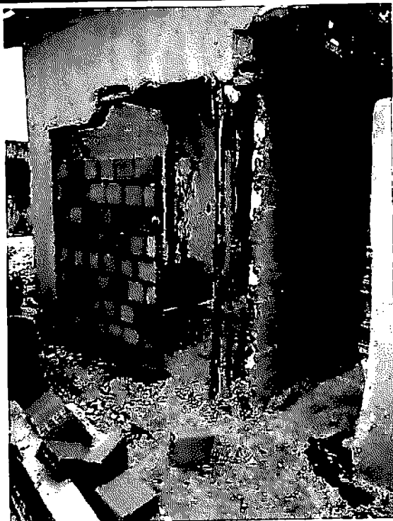
Foto 09: Alvenaria de Bloco.
