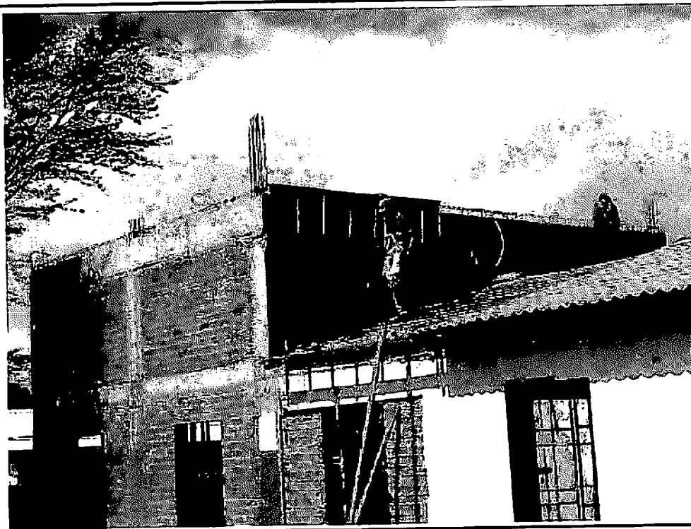
Foto 13: Concretagem Superestrutura.
